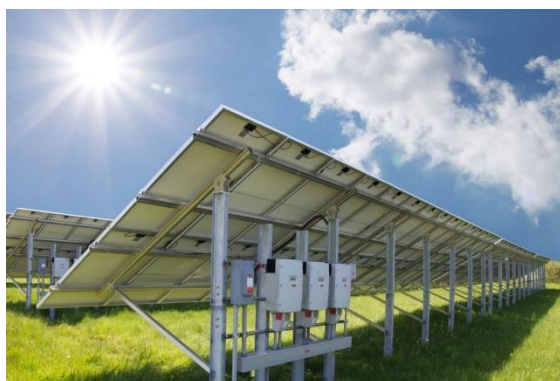
Exemple d'installations d'onduleurs décentralisés
