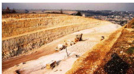
Le travail spectaculaire de cette déviation est sans conteste la percée du Rougemont dans le banc rocheux.
