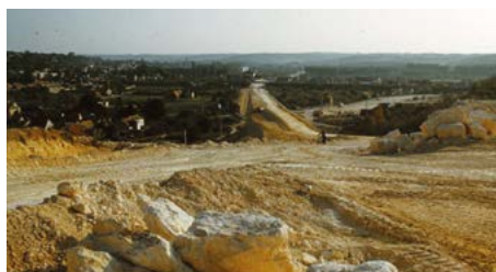
Pour assurer la stabilité du remblai sur tourbe, les ponts et chaussée ont prévu 5 800 puits drainants.
