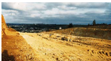
La tranchée principale du nouvel axe routier atteint une profondeur de 27 m et traverse successivement sur près de 6 km des marnes à meulière, une dalle calcaire et le fameux sable d'Étampes.
