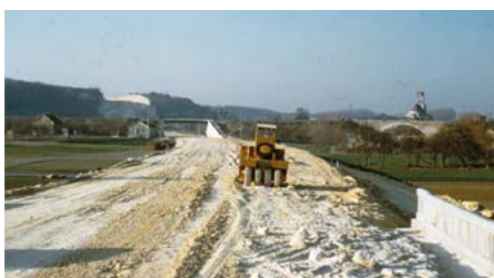
Le tracé de cette déviation emprunte la vallée tourbeuse de la Juine sur près de 4 km. La principale difficulté réside dans le remblai sur tourbe dont il faut assurer la stabilité.
