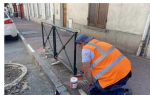
Le service Régie va procéder à la vérification et la réparation de scellement des mains-courantes. Le mobilier urbain sera aussi repeint si nécessaire.
