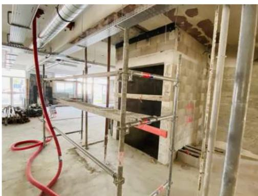
L'ancien ascenseur ne répondant plus aux normes d'accessibilité pour les Personnes à Mobilité Réduites (PMR), une nouvelle cage d'ascenseur a été créée. Les câblages électriques, les gaines de ventilation sont également en cours d'installation.
