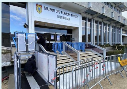
*En début de semaine, l'ancien enrobé devant l'entrée principale a été décaissé pour laisser place à un nouveau en béton désactivé. Sur le même secteur, un ascenseur pour personne à mobilité réduite a également été installé. L'entrée du bâtiment est ainsi parfaitement aux normes d'accessibilité pour accueillir tous les Étampois.*
