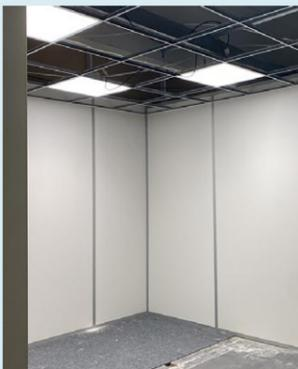
**Au rez-de-chaussée de la Maison des Services Publics Municipaux, l'aménagement continue. Des cloisons sont installées pour diviser les bureaux et les plaques de placo sont posées pour réaliser des contre-cloisons et servir de doublage isolant. Les plafonds et les sols sont repris.**
