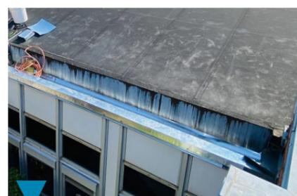
Au groupe scolaire Jacques-Prévert : changement d'un chéneau et d'une gouttière pour l'écoulement des eaux pluviales.
