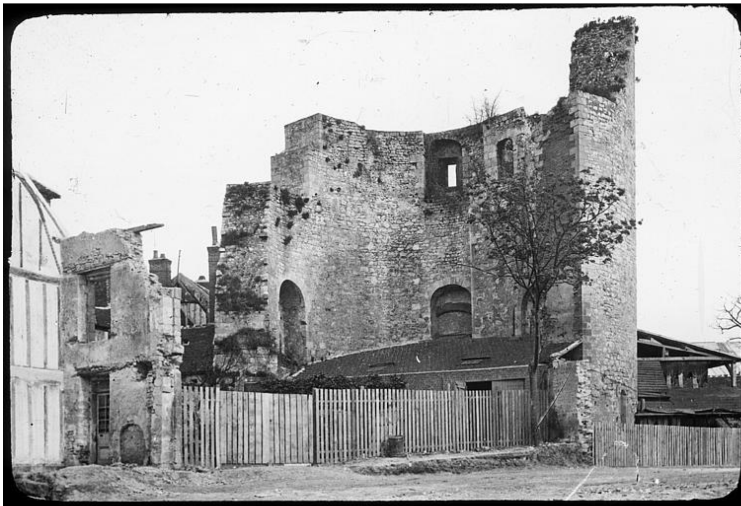
Page précédente et ci-contre : la tour « de Jeanne d'Arc », Compiègne [Clichés de Jean Jablonski, Médiathèque de l'Architecture et du Patrimoine]
