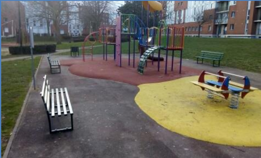
Rénovation de l'aire de jeux de la résidence de Guinette
